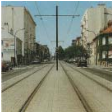
図 - 6 車道併設型 車道とは分離されておらず(段差 6 cm)軌道内の車両の通行が可能。ただし、トラムの通行が優先される。
