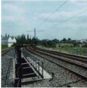
図 - 5 専用軌道型 他の交通とは完全に分離されている。SNCFの廃線跡地の有効利用など専用用地を確保。
